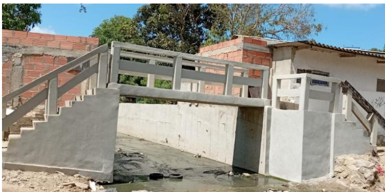
Imagen 80. Barandas en concreto de puente peatonal tramo principal.
