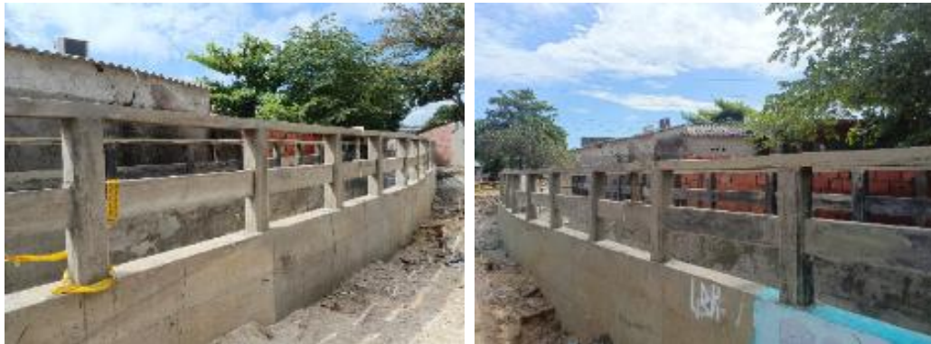
Imagen 84. Fundida de barandas en concreto tramo principal.
