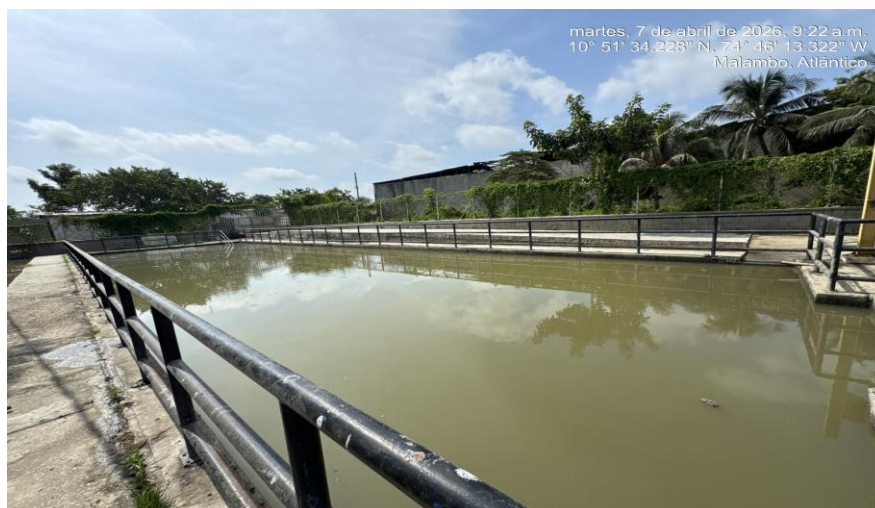
Imagen 42. Registro fotográfico Desarenador EBAR Malambo.
