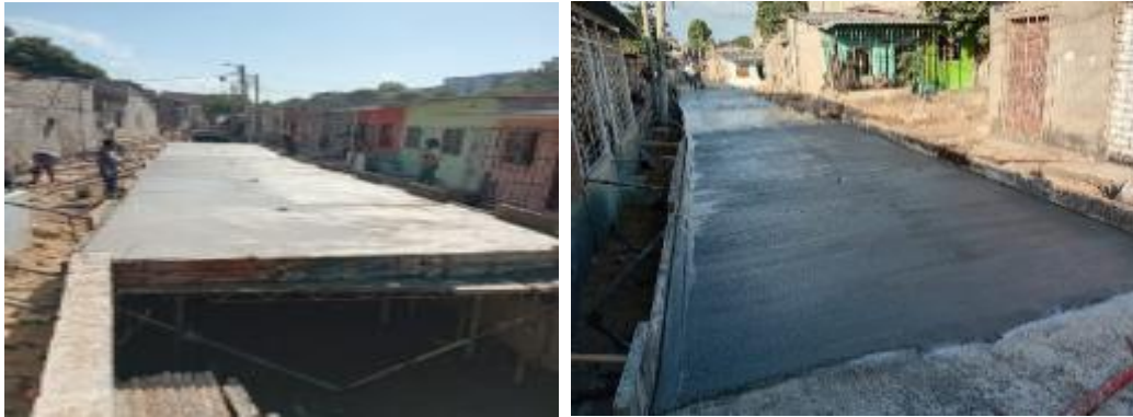
Imagen 83. Losa superior en concreto afluente 1.
