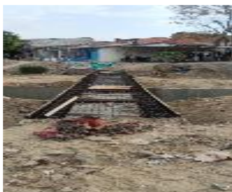
Imagen 87. Armado acero de refuerzo de puentes peatonales y vehiculares tramo principal.
