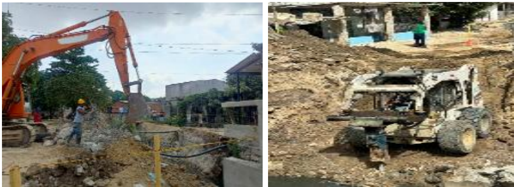
Imagen 85. Demoliciones en concreto tramo principal.
