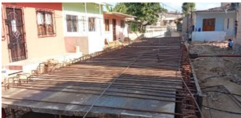
Imagen 81. Armado acero de refuerzo de losa superior Afluente 1.
