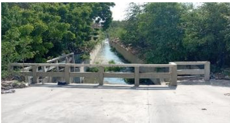
Imagen 88. Construcción de barandas en concreto Afluentes.
