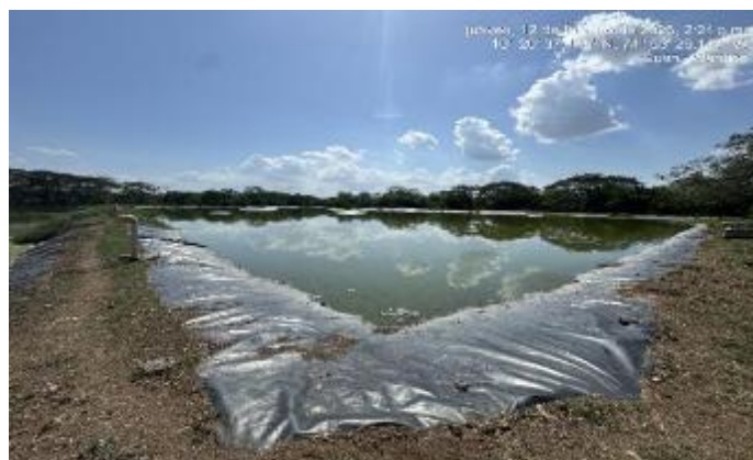
Imagen 41. Registro fotográfico Laguna facultativa 1 con presencia de elevaciones en la geomembrana.
