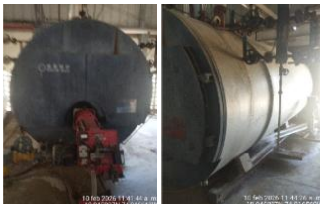
Imagen 69. Caldera para generación de vapor para la fabricación de bloques de icopor.
