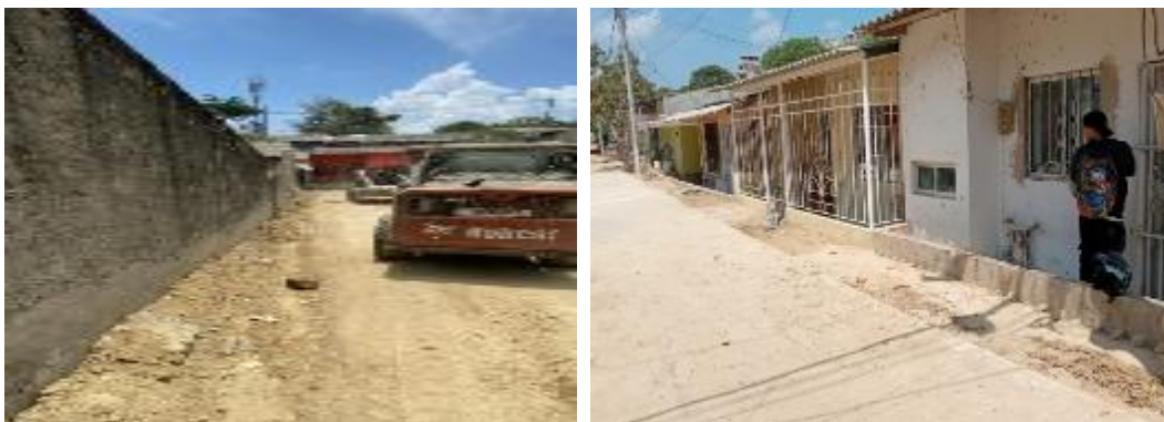
Imagen 89. Relleno recebo tipo estructural laterales de muros Afluentes.
