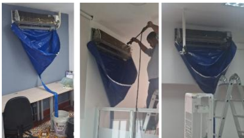
Imagen 118. Mantenimiento preventivo aires acondicionados.
