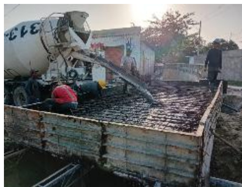
Imagen 87. Armado acero de refuerzo de puentes peatonales y vehiculares tramo principal.
