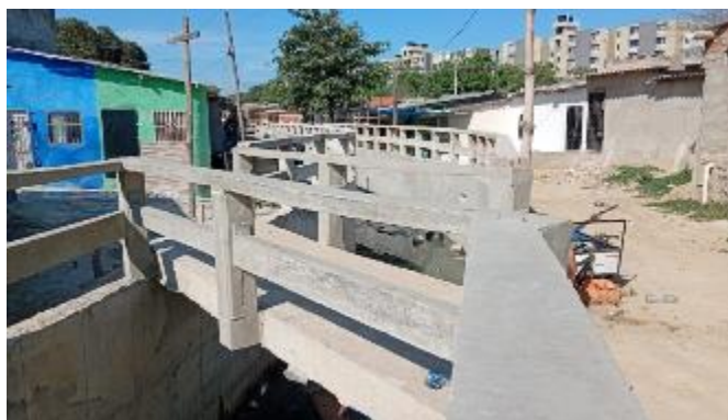
Imagen 90. Barandas en concreto de puente peatonales tramo principal.
